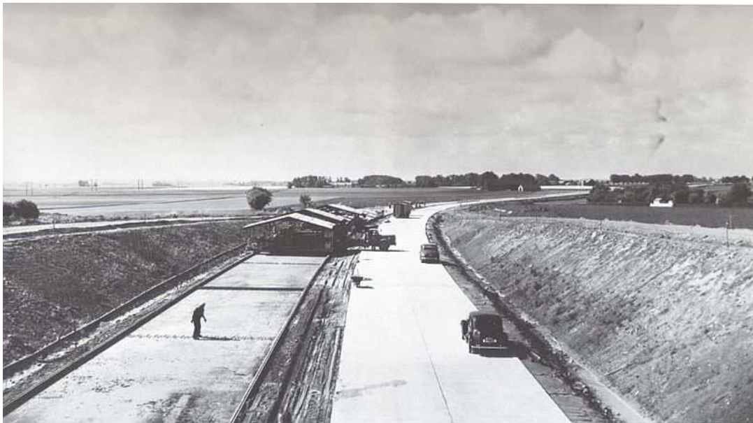
På bilden pågår beläggningsarbeten på det som ska bli Sveriges första motorväg.
